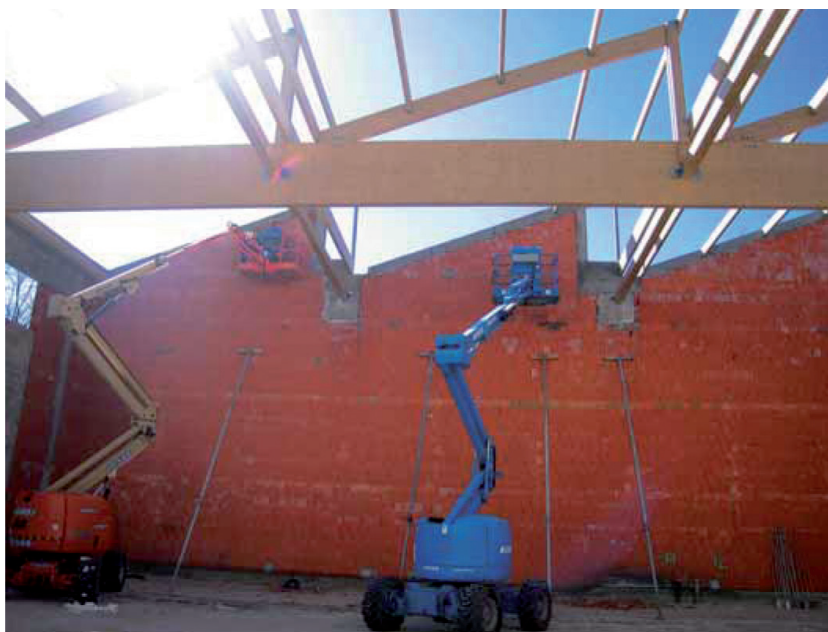
Lycée des métiers du BTP et de l'habitat HQE® de Blanquefort.
