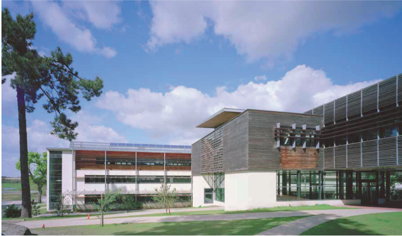
Lycée des métiers du BTP et de l'habitat HQE® de Blanquefort. Padiglione delle aule sul quale sono stati installati i pannelli fotovoltaici.
