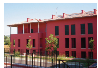
Fig 5. Massimo Gennari. Complesso residenziale, Cerbaia (FI) 2003-05.
