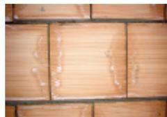
*Figura 2 - Posa in opera di elementi leggeri in laterizio a giunti sfalsati.*
